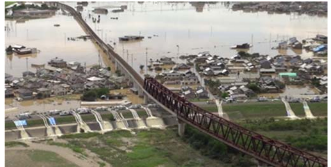
岡山県 倉敷市真備町
