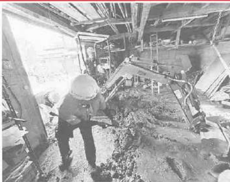
ミニコンボと人力で家屋の土砂を撤出
