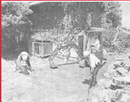
1m以上の高さとなった土砂や石を撤去
